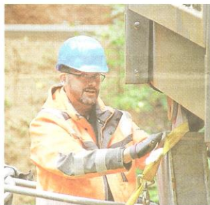
Christian Wilkens kontrolliert: Hier muss die obere Konstruktion auf den Pfeiler passen.
