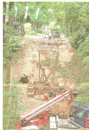
Die ersten Pfeiler stehen und werden die Brückenteile halten.
