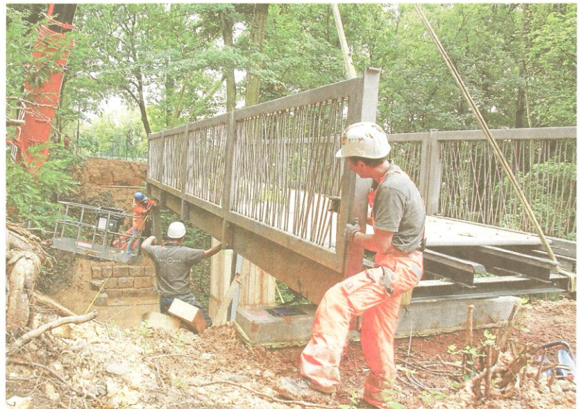
Die Brücke ist gedreht und muss auf die Pfeiler montiert werden. Fotos: Petra Hackert
