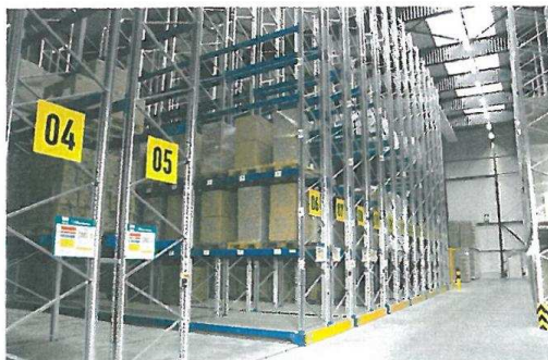
Die neue Lagerhalle innen und außen.
