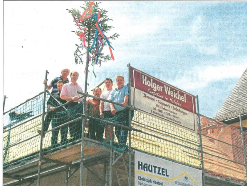
Das Dach ist dicht: Bauamtsleiter Reinhard Schäfer, Bauleiter Martin Hertlein, Architekt Oliver Hamm, Erster Beigeordneter Burkhard Hölz, Zimmermann Holger Weichel und Bürgermeister Thorsten Sprenger (von li.) feiern Richtfest. (Foto: A. Weill)
