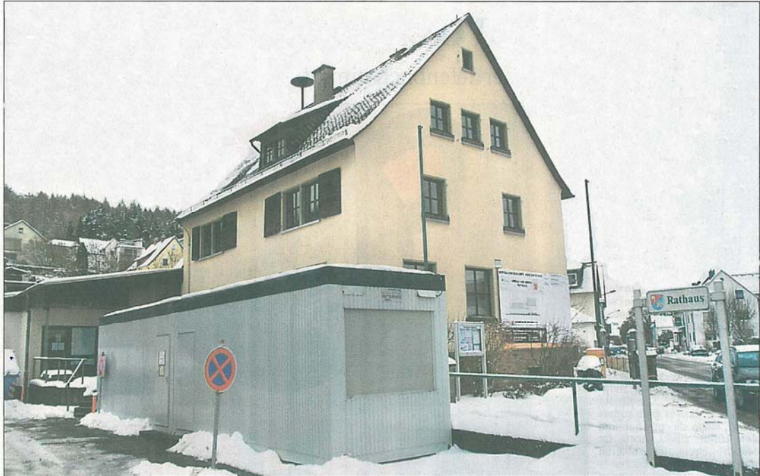
Solange das Weinbacher Rathaus umgebaut wird, ist die Post in einen Container (im Vordergrund) ausgelagert worden. (Foto: Henss)
