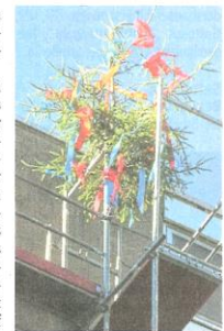
Feststimmung: Bunte Bänder wehen am Richtbaum über dem Erweiterungsbauteil. (Foto: Vetter)
