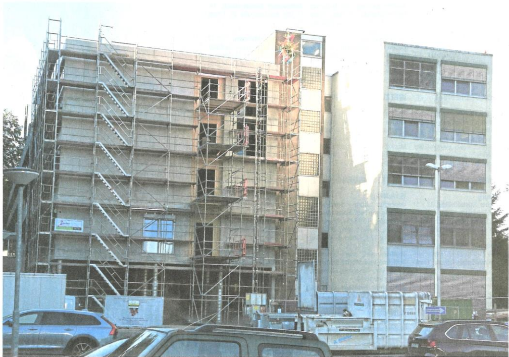
Der Rohbau steht: Durch die Erweiterung wird Platz geschaffen für eine neue Intensivstation und für mehr Zweibettzimmer im Kreiskrankenhaus Weilburg.
