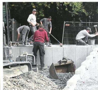
Hier haben die Bauarbeiter schon die Regie übernommen. (Foto: Vetter)
